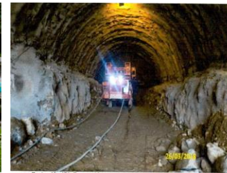
Túnel 5. Portal Villavicencio
