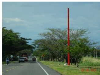
Poste S.O.S. K15+460 UF1. Fuente: Anexo 4 Reporte de Ingeniero Independiente
