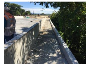
Puente nuevo K185+745 UF5. Fuente: Anexo 4 Reporte de Ingeniero Independiente
