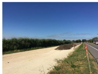
Acopio de subbase K187+616 sector doble calzada UF5. Fuente: Anexo 4 Reporte de Ingeniero Independiente
