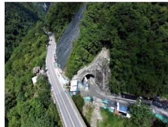
Túnel 1. Portal Villavicencio
