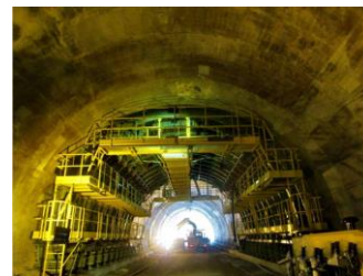
Túnel 6. Formaleta de revestimiento
