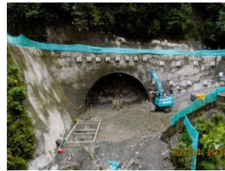
Túnel 2. Portal Villavicencio
