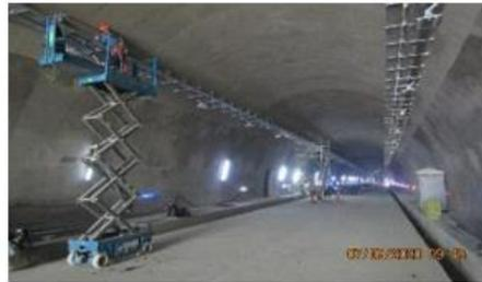
**Túnel 3. Instalación de bandejas portables Portal Bogotá**
