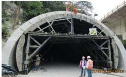
**Túnel 2 – Formaleta falso túnel Portal Bogotá**
