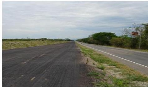
**Imprimación de emulsión asfáltica UF2 (segunda calzada)**
