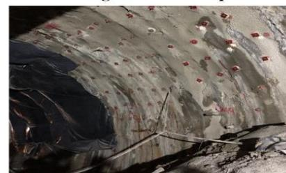
**Túnel 7. Instalación de pernos en zona de falla**
