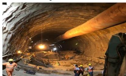
**Túnel 7. Excavación de solera (contrabóveda)**
