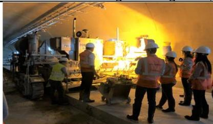
**Túnel 1. Pavimentadora de encofrado deslizante**
