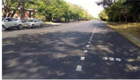
Pavimento y señalización terminada – UF3
