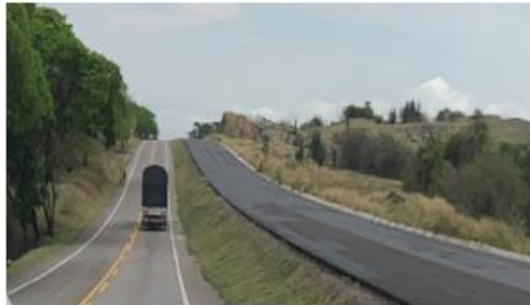
Estructura de pavimento terminada– UF2
