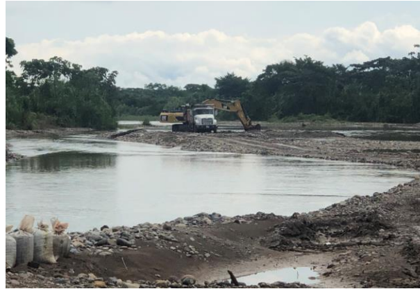
Extracción de material pétreo del río Aipe. Fuente: visita de campo 11 de marzo de 2020.
