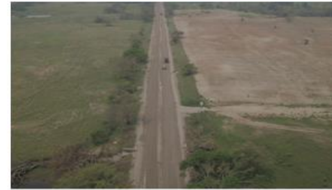
Carpeta asfáltica levantada – UF3
