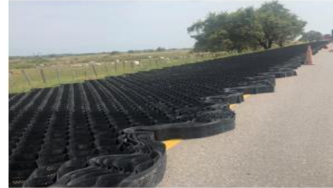
Reforzamiento del pavimento con geoceldas – UF3
