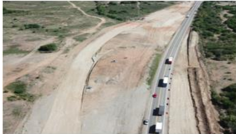
Movimiento de tierras segunda calzada- UF2
