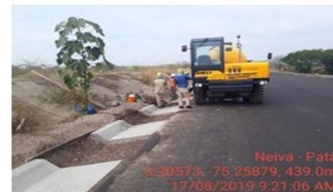
**Fundición cunetas de concreto – UF2**
