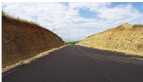
**Corte de talud y extensión de primera capa de asfalto – UF2**
