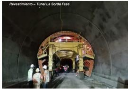
UF7. Revestimiento Túnel La Sorda
