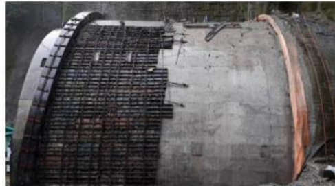
Túnel 2. Fundida y desencofrado del túnel falso
