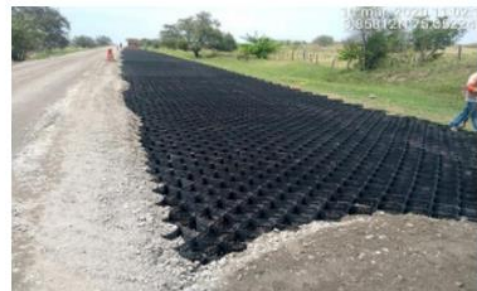
UF3. Instalación y vaciado con material granular
