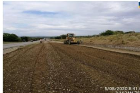
UF2. Conformación subbase granular
