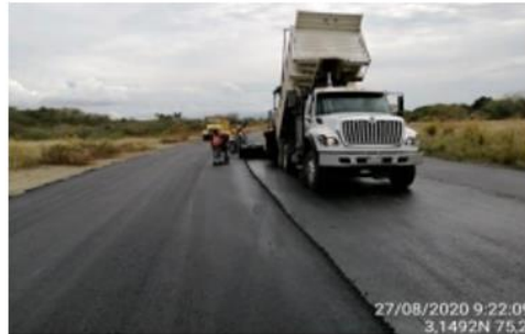
UF2. Instalación de mezcla asfáltica
