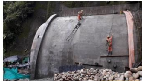
Túnel 2. Fundida y desencofrado del túnel falso
