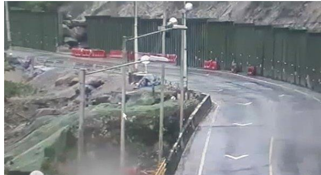
Caída de piedra atrás del tablestacado el 23 de septiembre de 2020
