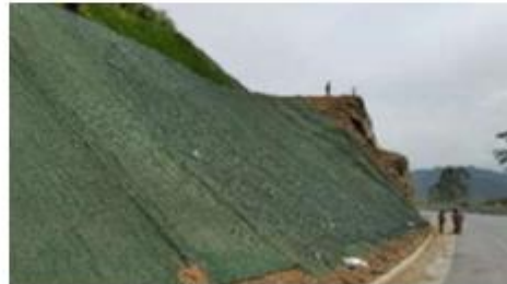
Estabilización de talud K3+500 - UF3. Fuente: IE
