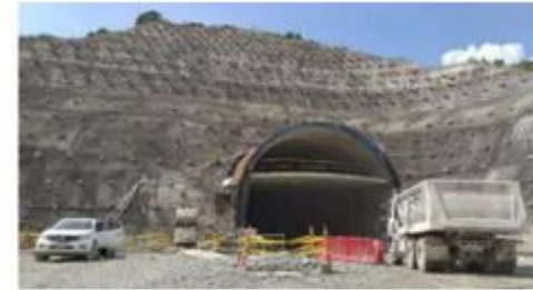
Túnel de Tesalia Portal de Salida – UF2. Fuente: IE
