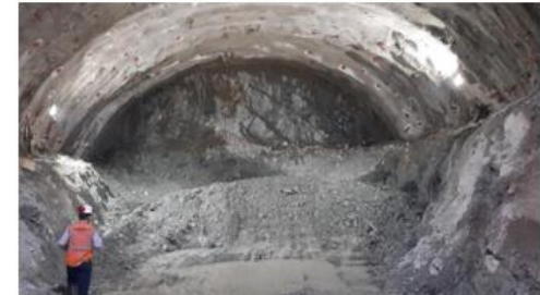
Túnel 7. Excavación mecánica en nicho de parqueo
