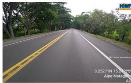
UF3. Rehabilitación estructural
