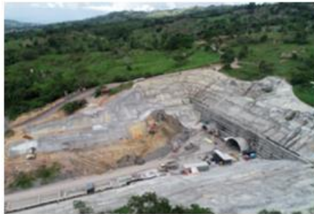
UF6. Portal de Salida Túnel La Paz
