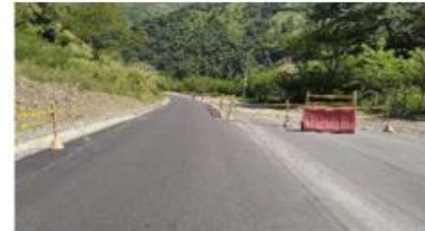
Instalación de pavimento– UF5. Fuente: IE
