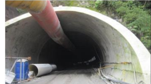
Túnel 7. Instalación de equipos de ventilación
