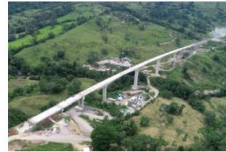
UF7. Viaducto de Río Sucio
