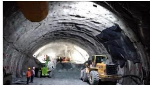
Túnel 7 - Portal Bogotá. Realización de sondeos
