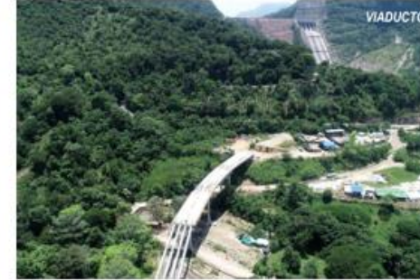
UF5. Viaducto San Silvestre
