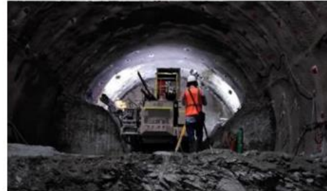
Túnel 7 - Portal Villavicencio. Enfilaje
