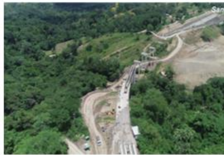
UF5. Viaducto La Peligrosa
