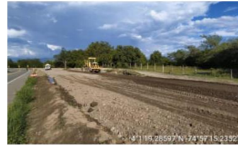
UF4. Extendido y compactación de segunda capa subbase
