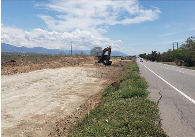
**Fotografía 9.** Actividades de descapote. Material de corte empleado para terraplenes, separadores y relleno de estructuras – UF2B
