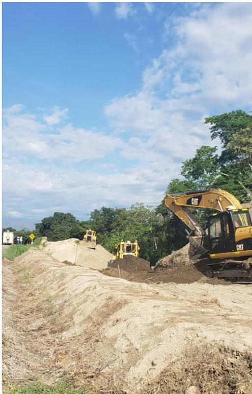
**Fotografía 11.** Actividades de descapote. Material de corte empleado para terraplenes, separadores y relleno de estructuras – UF4A
