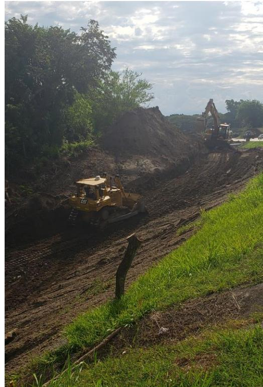
**Fotografía 12.** Actividades de descapote. Material de corte empleado para terraplenes, separadores y relleno de estructuras – UF4A
