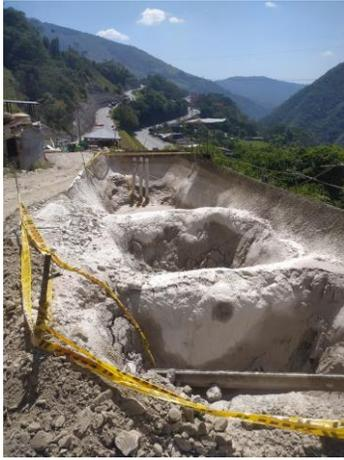
**Fotografía 5.** Sistema de tratamiento de aguas de excavación desmantelado en túnel 5 portal Villavicencio
