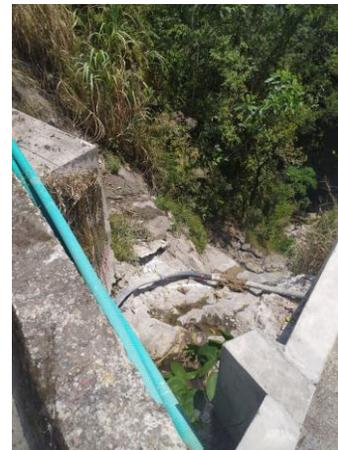
**Fotografía 5.** Punto de entrega de aguas lluvias captadas en ZODME 1, a un drenaje que entrega sus aguas a la quebrada Pipiral, se observa buena estabilidad en el cauce sin presencia de procesos de socavación (se hace esta aclaración dados los altos volúmenes de agua captados)
