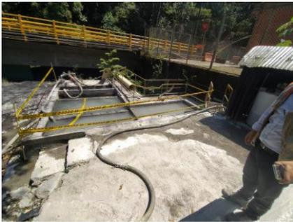
**Fotografía 5.** Sistema de tratamiento de aguas de excavación en operación en túnel 7 portal Bogotá
