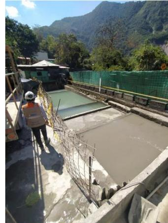
**Fotografía 4.** Sistema de tratamiento en operación túnel 3 galería, se observa un sistema con alta concentración de sólidos
