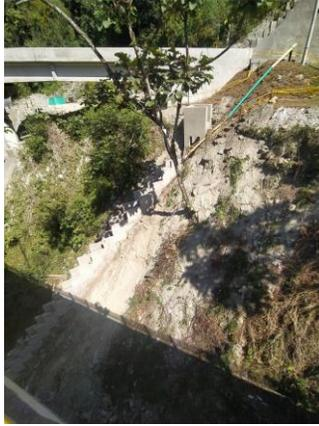
**Fotografía 1.** Talud asociado al puente La Pala, se tiene proyectado lanzamiento de concreto, esta es la obras más representativa que está por ejecutar en la UF 01.
