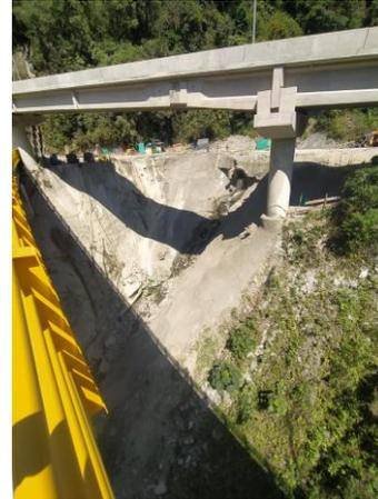
**Fotografía 2.** Quebrada La Pala, que cruza adelante del portal Villavicencio en el túnel 1, se observa importantes avances en la protección del talud, obras en ejecución.
