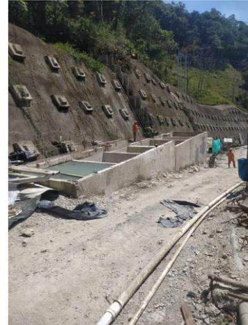
**Fotografía 5.** Sistema de tratamiento de aguas de excavación desmantelado en túnel 5 portal Villavicencio
