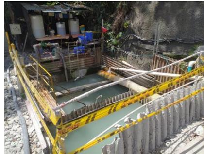
**Fotografía 5.** Sistema de tratamientos secundario en operación túnel 7 portal Bogotá
