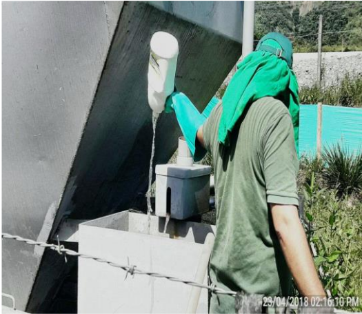
Foto 5-1. Aplicación hipoclorito de sodio, soda cáustica y ácido muriático para eliminar costras sedimentos retenidos y realizar la purga del sistema (La aplicación se realizó en el clarificador).
