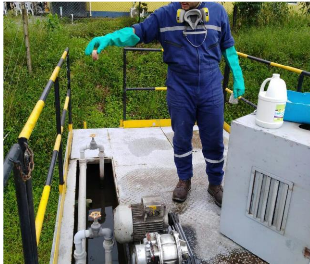
Foto 5-2. Aplicación de 85g de bacteria sólida TG-80
