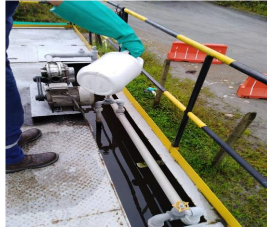
Foto 5-1. Aplicación hipoclorito de sodio, soda cáustica y ácido muriático para eliminar costras sedimentos retenidos y realizar la purga del sistema (La aplicación se realizó en el clarificador).
