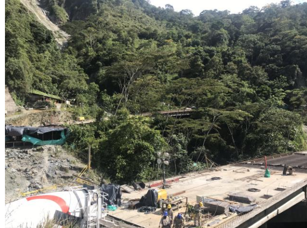
Fotografía 2. Durante el recorrido se evidenció bajo impacto en zonas aledañas a las obras ejecutadas.
