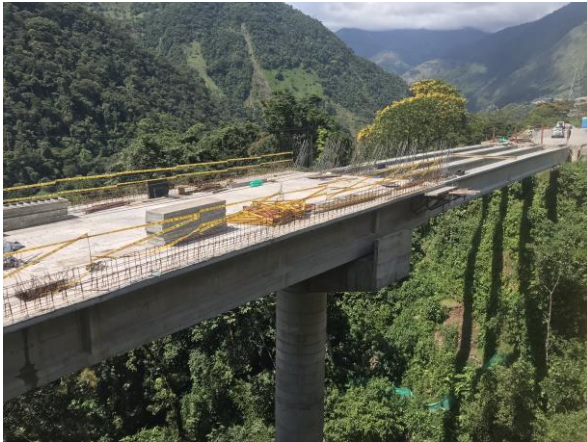
Fotografía 5. Durante el recorrido se evidenció bajo impacto en zonas aledañas a las obras ejecutadas
