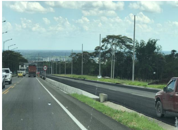
Fotografía 4. Avances en el tramo de calzada de la UF6, se observa adecuada revegetalización de áreas aledañas
