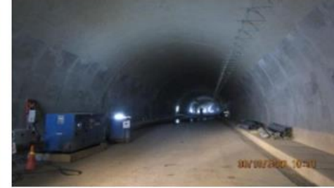
Túnel 5. Instalación de ductos de ventilación
