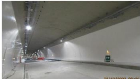
Túnel 2. Primera capa de pintura del túnel
