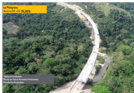
UF5. Viaducto La Peligrosa
