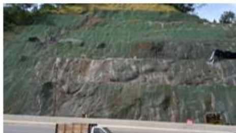
Estabilización de talud K3+800 – UF5. Fuente: IE
