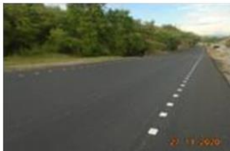
UF2A. Conformación de mezcla asfáltica
