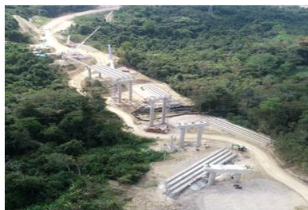
UF5. Viaducto II
