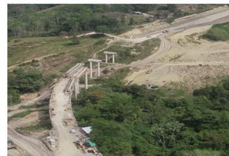
UF5. Viaducto San Silvestre
