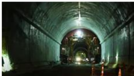
Túnel de Tesalia Portal de Entrada – UF2. Fuente: IE
