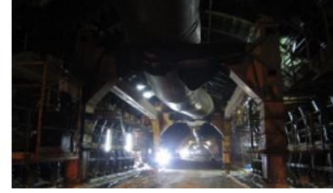
Túnel 7. Instalación de equipos de ventilación
