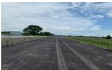
UF4B. Pavimentación en primera capa
