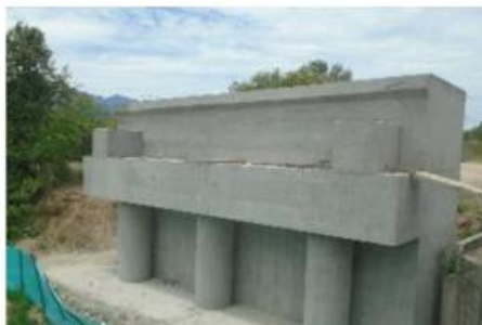
UF2A. Puente Dindal
