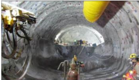
Túnel 7 - Portal Bogotá. Realización de sondeos
