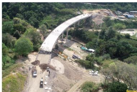
UF5. Viaducto I
