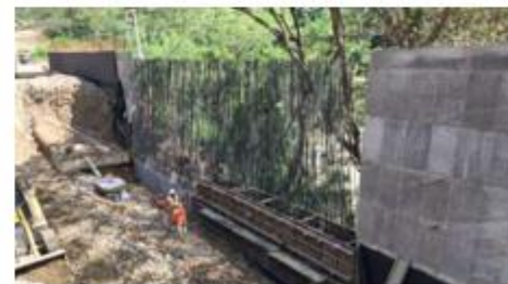
Construcción de muro de refuerzo – UF5. Fuente: IE
