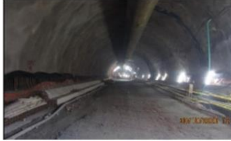
Túnel 7 - Portal Villavicencio. Enfilaje
