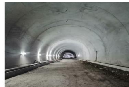
UF7. Túnel La Sorda
