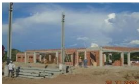
UF3. Construcción de Peaje Patá
