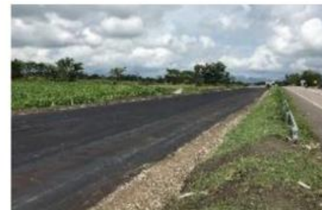
UF4A. Pavimentación en primera capa
