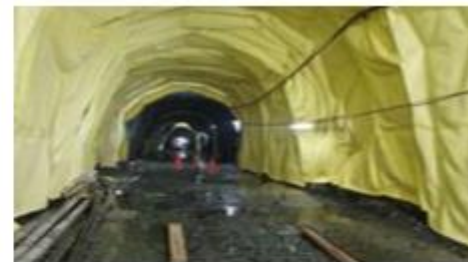
Túnel de Tesalia Portal de Entrada – UF2. Fuente: IE
