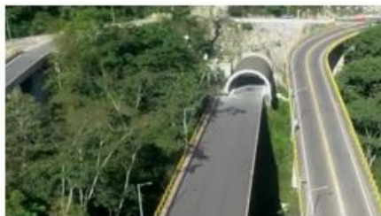
Túnel 5. Túnel Falso Portal Bogotá
