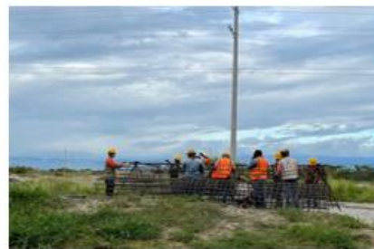
Armado de acero
