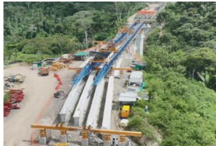
UF7. Puente Quebrada La Sorda
