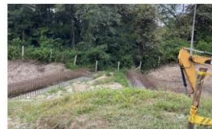
Armado acero e instalación
