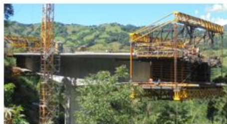
Km90 Puente A – UF5. Fuente: IE
