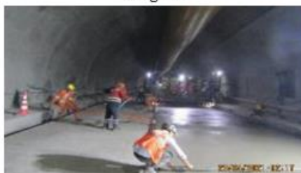
Túnel 7 - Portal Villavicencio. Fundida de losa de concreto
