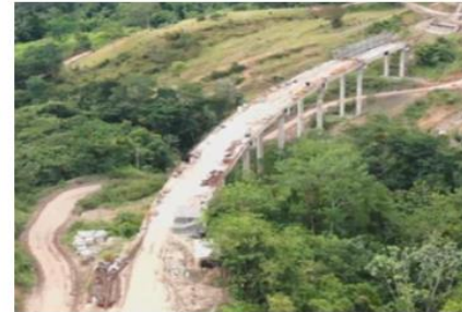
UF5. Viaducto San Silvestre
