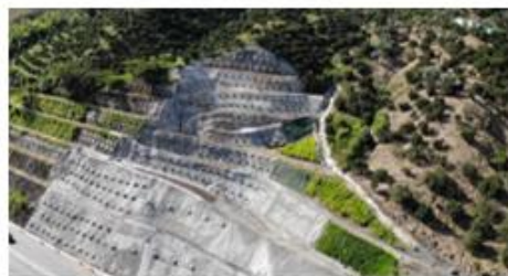
Km 6 Estabilización de talud - UF3.2. Fuente: IE
