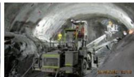
Túnel 7. Portal Villavicencio. Excavación y presoporte
