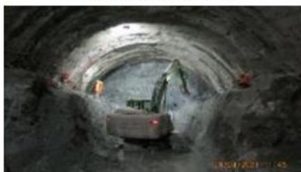
Túnel 7 - Portal Bogotá. Excavación y presoporte
