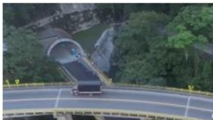
Túnel 2. Portal Villavicencio. Adecuaciones red ITS
