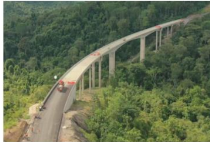
UF5. Viaducto La Peligrosa
