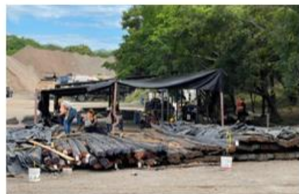
Figuración de acero en talleres
