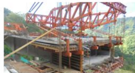
Km91 Puente B - UF5. Fuente: IE
