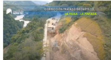
**Corrección de trazado geométrico - UF5.** Fuente: Concesionario
