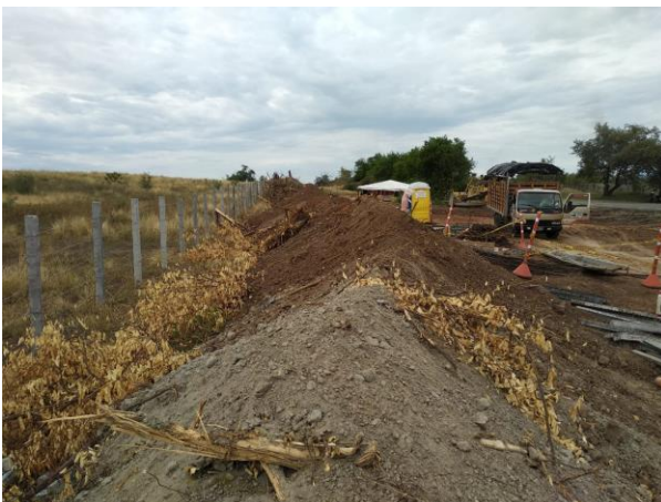
Fotografía 3. Jarillón conformado en el costado externo de la nueva calzada, se tiene riesgo de arrastre de sedimentos fuera del DDV, este material podrá ser utilizado para reconfiguración de otras áreas.
