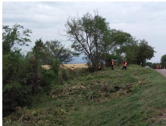
Fotografía 6. Frente de obra de talas ejecutando actividades en la UF4. Se observó un adecuado conocimiento de los responsables del frente de obra, en relación a los autorizado a talar.
