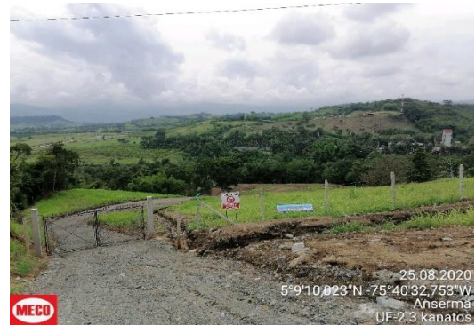
UF 2.3 Kanatos ZODME restoration
