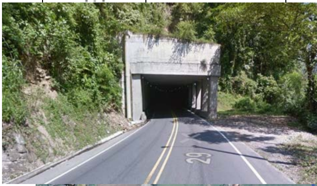
Ilustración 13. Puente de Irrá (existente) UF4
