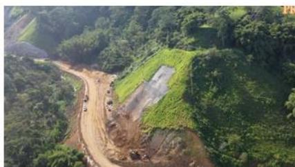
**UF8. Estabilización de talud K100**
