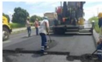
UF4A – Extensión segunda capa asfalto
