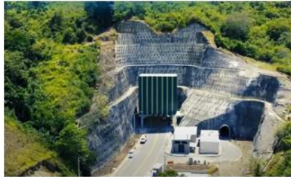
UF2. Portal Entrada
