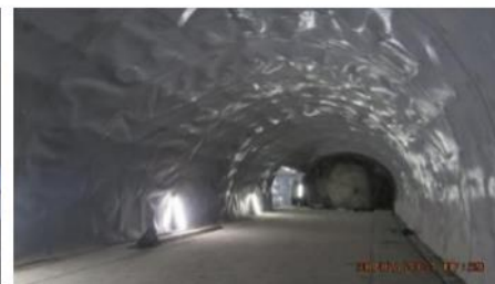
Túnel 7. Galería 1. Instalación de membrana
