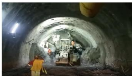
Túnel 7 - Portal Bogotá. Excavación y presoporte
