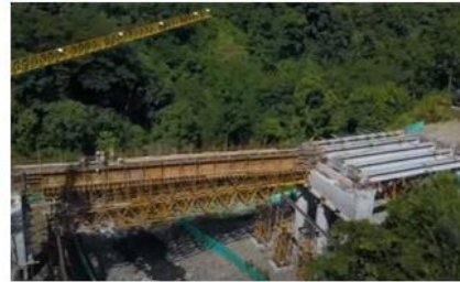
UF5. Puente A
