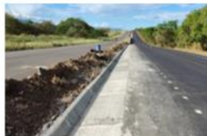
UF2B - Construcción de Cunetas
