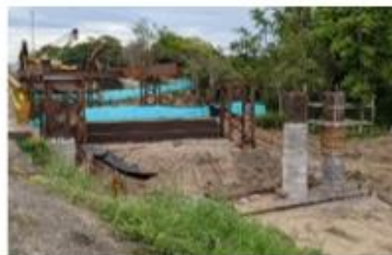
UF2B – Puente Baché
