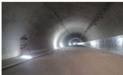
UF7. Túnel La Sorda
