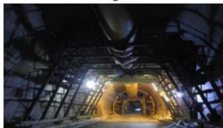
Túnel 7 - Portal Bogotá. Avance de revestimiento
