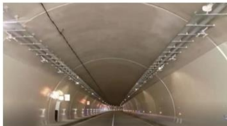
Túnel 2. Portal Villavicencio. Adecuaciones red ITS
