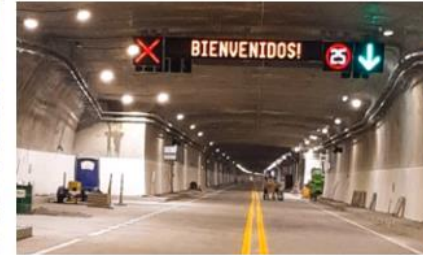
UF2. Instalación de equipos electromecánicos y señalización
