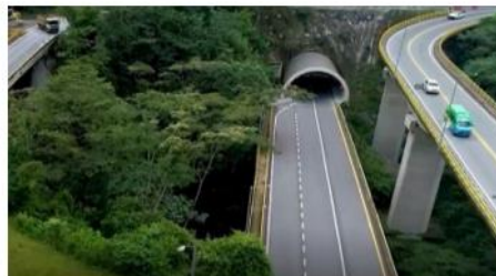
Túnel 2. Túnel Falso Portal Bogotá
