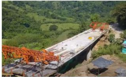
UF5. Puente B
