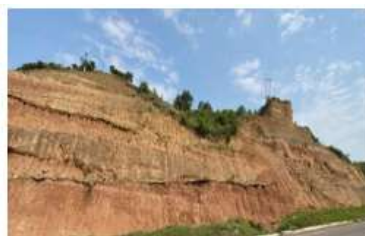
UF2A. Taludes K23
