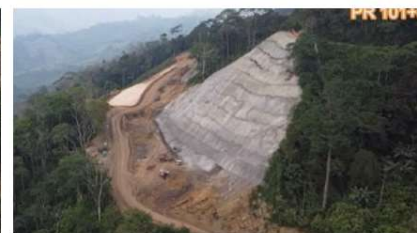
UF8. Estabilización de talud K101
