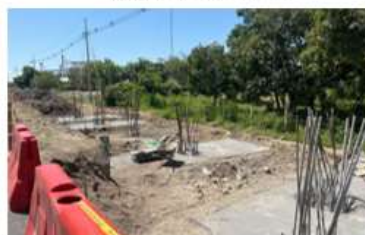
UF2A. Puente peatonal Santa Bárbara
