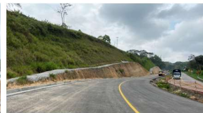
UF9. Estabilización de talud K115
