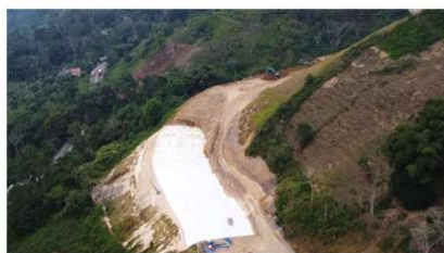
UF8. Estabilización de talud K100
