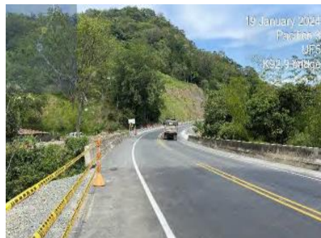
UF5 - Trabajo del puente K92,8
