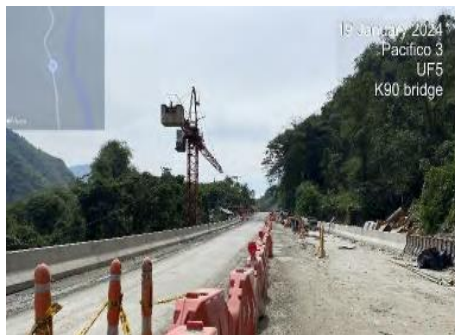
UF5 - Trabajos del puente K90
