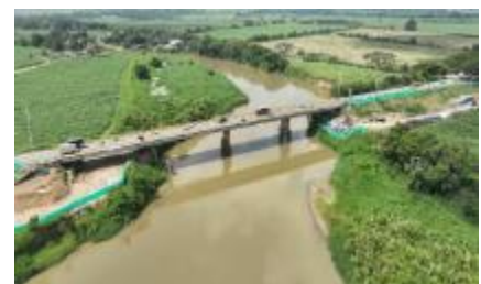
UF4 – Puente Guillermo Leon Valencia
