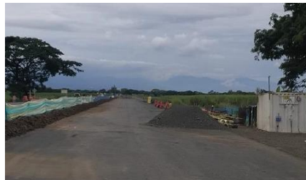
UF4 – Instalación sub base y capa intermedia
