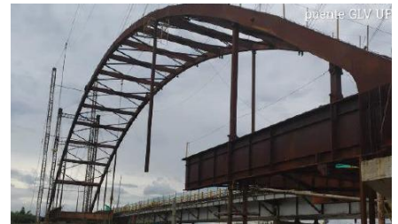
UF4 – Puente sobre el Río Cauca
