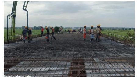
UF3 – Puente Potrerillos Tablero
