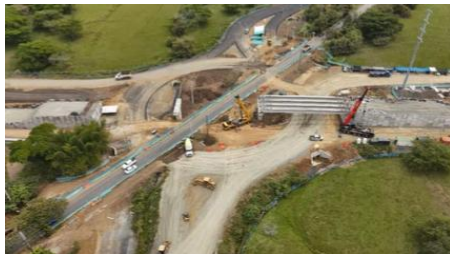
UF3 – Intersección Puerto Tejada
