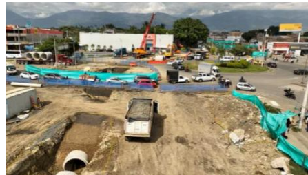
UF1 – Construcción Intersección Versalles
