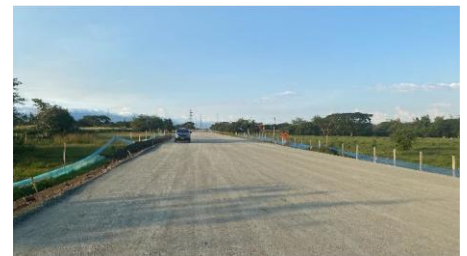
UF3 – Construcción Av. Bicentenario
