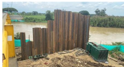
UF4 – Obras de protección río Cauca
