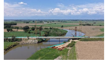
UF4 – Puente sobre el Río Cauca
