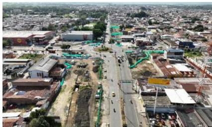
UF1 – Construcción Intersección Versalles
