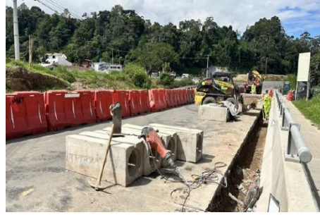
UF6 – Puente Río Blanco
