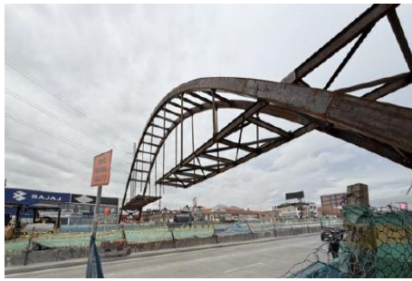
UF8 – Puente Peatonal El Dorado
