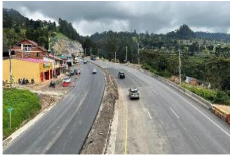
UF6- Rehabilitación tercer carril
