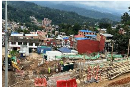
UF6 – Terraplen Molino Rojo
