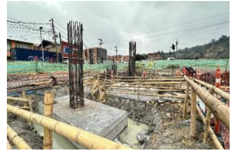
UF8 – Cimentación puente peatonal
